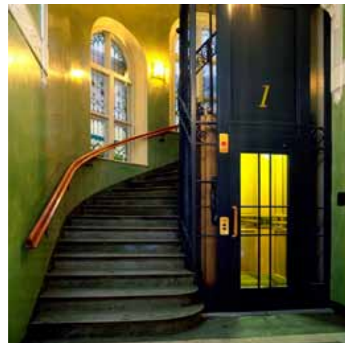
Alla hissdörrar i arbetslokaler måste numera förses med en innerdörr. Foto: Hissgruppen
